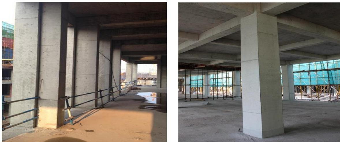
(3) 梁柱节点角、线、面清晰顺直，无爆模胀模，无蜂窝麻面。
