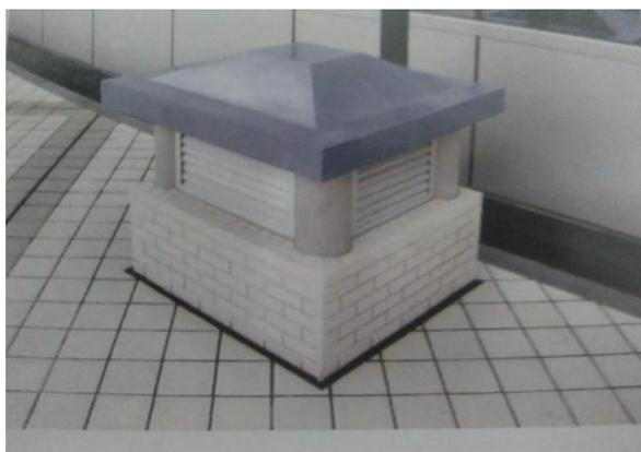
说明：确定排烟（风）道尺寸、立面高度宜为 0.8-1.0m，顶面坡度为 10%。顶部应嵌分隔条或铜条，所有阳角及风帽顶面交接线均应镶嵌。顶部底面四周距外沿 20-30mm 处应设滴水槽。
