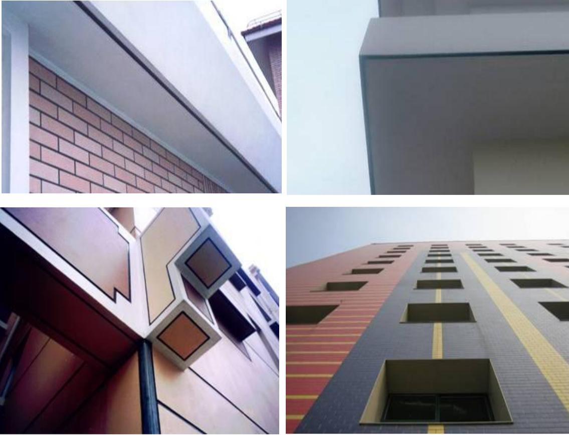
说明：窗台、窗楣、檐口、雨棚、阳台、压顶、腰线等部位应做滴水槽。滴水槽应采用 PVC 分格条，离外边沿尺寸为 30-40mm，距两端墙面为 50mm 处应断开引出做截水处理。平角及转角部位处应裁割成 45° 拼接，表面与粉刷平齐，在涂料涂刷前应贴美纹纸保护，涂刷后清理干净或用油漆补刷。
