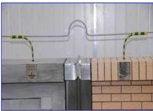
避雷带安装时，转角及过屋面伸缩缝处应设“Ω”弯。
