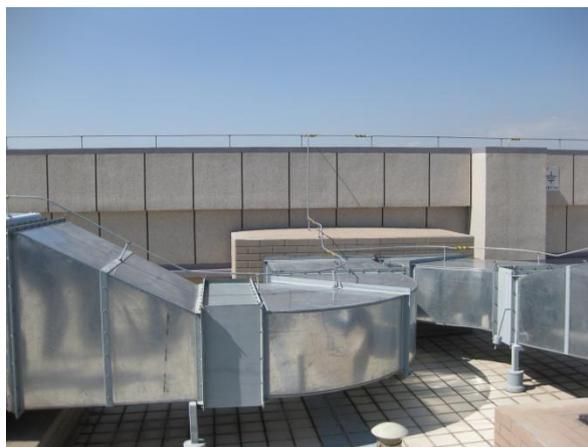
表面平整度差等质量缺陷。用电脑控制自动加工机械制作矩形镀锌薄钢板风管，应用的是“金属矩形风管薄钢板法兰连接技术”或称共板法兰（法兰与风管共体），已被北京、上海、广东等省市广泛采用。应注意的一是矩形薄钢板风管四角棱处开口不宜过长，满足翻制法兰长度即可，法兰翻制后，开口处应涂以密封胶，防止漏风；二是加工成L形或口形运到施工现场合缝宜采用专用合缝设备，保证合缝严实；玻璃钢风管加工时应注意表面的平整度及风管的强度，法兰与风管连接处应圆弧过渡，不应成直角，法兰螺栓孔距应相等。
