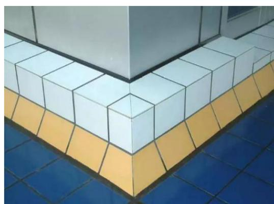
说明：管道及支架根部可做成正变形护墩，尺寸及形状由现场确定（图中样式仅供参考）。管道及支架根部应做找平层且应居护墩中心。混凝土护墩基体浇筑完成后粘贴饰面砖，饰面砖拼接缝应倒角，拼接严密。在护墩顶面可贴面砖或砂浆面嵌铜条，位置与多边形角部连通，向外 10%找坡，水泥砂浆顶面应密实平整，收压抹光。石材护墩石材应统一加工，阳角处倒角拼接。采用云石胶粘贴固定，石材平面压立面；护墩与管道、屋面及护墩错台处应打胶密封。同规格、同拍、同形式护墩宜成行成排、大小一致。
