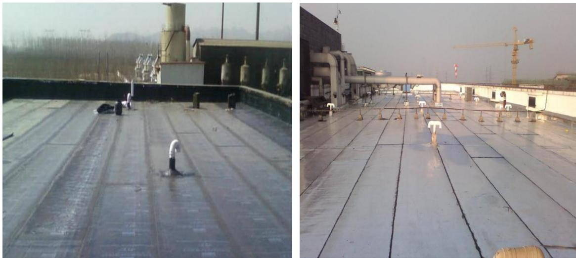
说明：（1）找平层表面应压实，排水坡度应符合设计要求；（2）基层与突出屋面结构（女儿墙、立墙、天窗壁、变形缝等）的连接处，以及基层的转角处（水落口、檐口、天沟、檐沟、屋脊等），均应做成圆弧。
