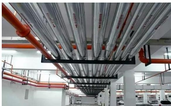
飞边毛刺处理干净，统一进行防腐除锈涂漆。同时管道上的卡环，也根据不同管径统一下料、套丝、煨制，也可避免这方面的质量通病的发生。
