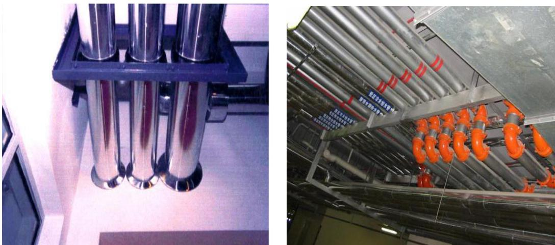
2.1.2 采暖、消防、燃气管道及硬聚氯乙烯管道穿墙（楼板）应按规定加设套管。套管的设置若无设计要求时，一般按规定：套管应安装牢固不松动，比管道大二个规格，套管与管道之间间隙均匀，套管突出墙面装饰层 20mm，间隙用封堵材料塞实，且套管之间缘口平齐。安装在楼板内的套管，其顶部应高出地面 20mm。用水量较大的地方（如卫生间内）应高出地面 50mm，底面与楼板面平齐，安装在墙壁内的套管，其两端应与饰面平齐，做到美观、整洁。
