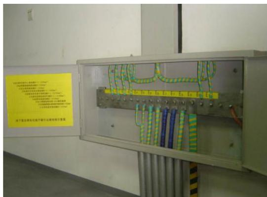
分别与汇流排连接（PE 线应用双色标准铜芯线）；接线端子编号清晰，工整，器件控制的设备名称，编号均应标识，柜、箱内做到清晰美观，导线绝缘良好。
