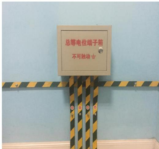
电箱电气管较多，其并排敷设进箱要保证管子平整，间距均匀，配电箱开孔采用开孔器开孔，孔洞圆滑平整，一管一孔，不可开长孔。
