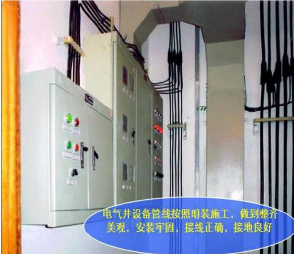
电气井设备管线按照明装施工，做到整齐美观，安装牢固，接线正确，接地良好
