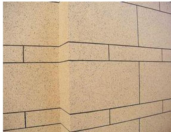
说明：涂饰墙面，应按排版图弹线，设置起房裂缝及装饰效果的分隔缝，设计无要求时，应沿窗洞口上下及两侧分格，水平及竖向间距不宜大于 3m。
