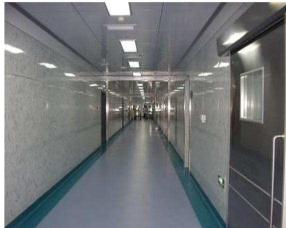
具体排版要求：（1）灯具、烟感、喷淋、风口等居中对称，成行成线，分布均匀。（2）与墙面连接处宜留 15-20mm 凹槽（采用 W 型边龙骨）。
