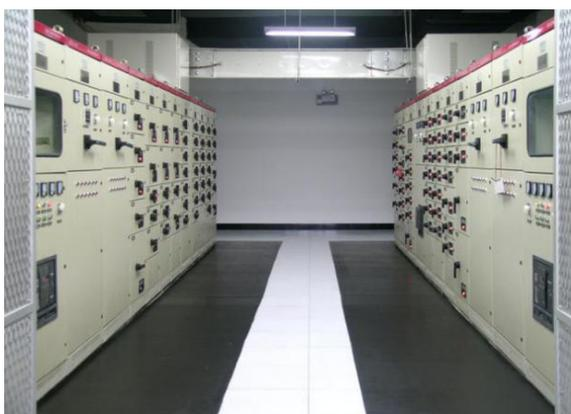
PVC 塑料管进入配电箱，盒应用锁母护口固定。配电柜、箱等金属框架及基础型钢必须接地（PE）或接零（PEN）可靠；装有电器的可开启门，门和框架的接地端子间应用裸编织铜线连接，且应标识；配电柜、箱上的绝缘子底座，套管的法兰、保护网及母线支架等可接近裸露导体应做可靠接地或接零，并不可作为接地或接零的接续导体。
