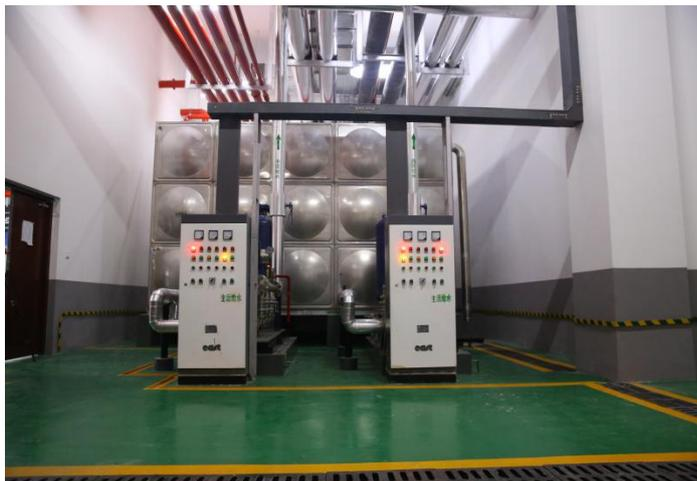
落地式安装的配电柜底部抬高，室内高出地面 50mm 以上，室外高出地面 200mm 以上，底座周围封闭严密。成套配电柜、控制柜金属框架及基础型钢必须接地（PE）可靠；装有电器的可开启门，门和框架的
