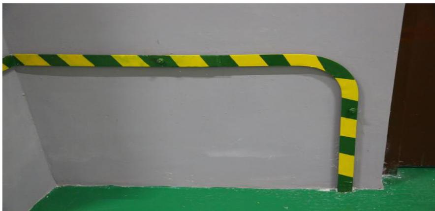
丝扣连接的明配镀锌管的接地跨接、成排电气配管接地跨接应用黄绿线压接到专用接地卡中，接地卡高度应一致，跨接线布排整齐。
