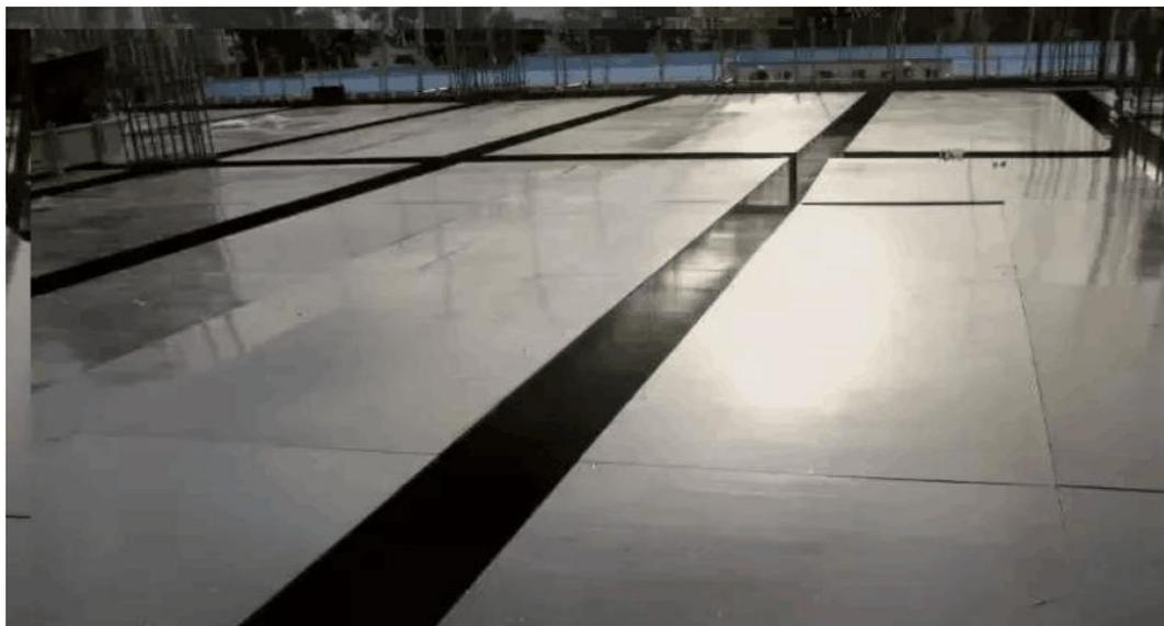
配模时梁柱节点、梁梁节点作为工序控制的重点,对确保混凝土成型后的观感质量非常重要。
