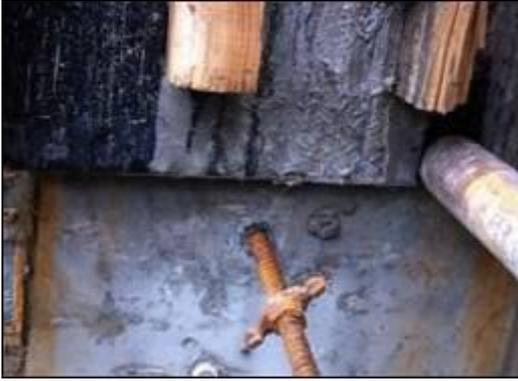
图5 螺杆安装方法
