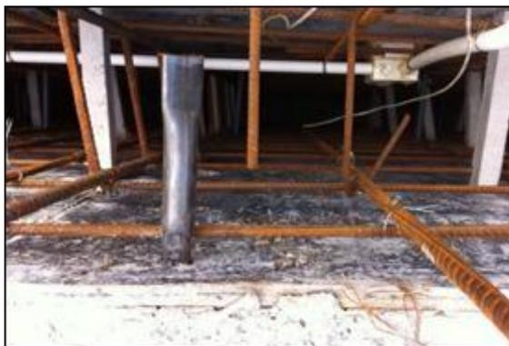
图 3 安装好的套筒
